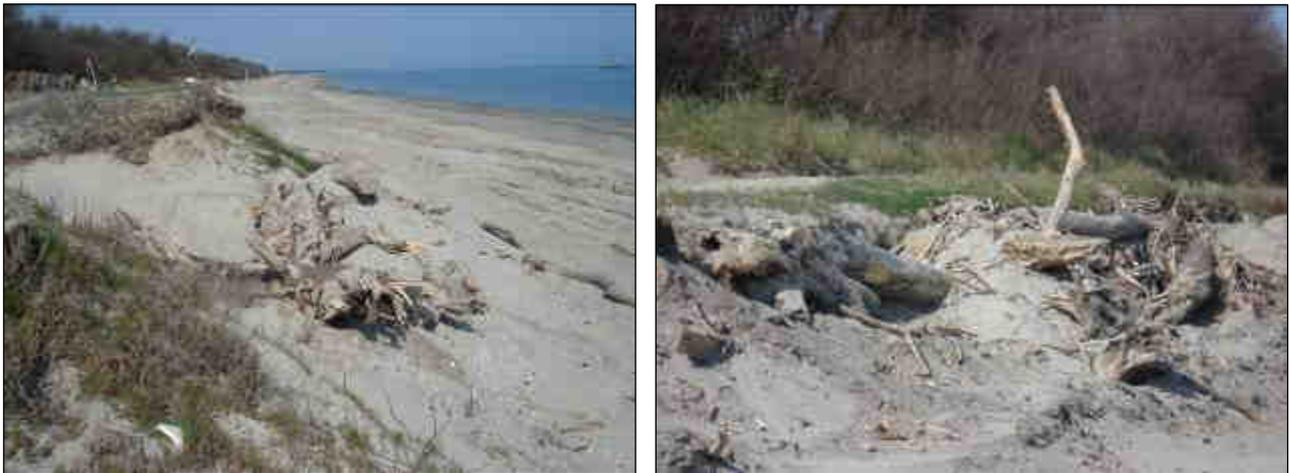
Figure 3 – Exemples de troncs et de branchages déposés sur le flanc marin du cordon dunaire lors de l'intervention de reconstruction des dunes du Lido delle Nazioni (Regione Emilia-Romagna).
