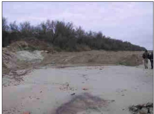
Figure 2 – a) Tamisage du sable et b) versement du matériel sur la plage. L'exemple provient de l'analyse réalisée par l'Université de Ferrara dans le cadre d'un projet de reconstruction des dunes du Lido delle Nazioni (Regione Emilia-Romagna). Durant l'intervention environ 22.000 m<sup>3</sup> de sable ont été transportés et versés sur la plage objet d'intervention.
