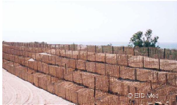
Figure 2 – Protection du bourrelet sableux contre l'érosion éolienne (année  $n$ ).
