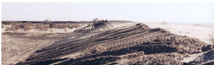
Figure 1 – Mise en forme mécanique du bourrelet sableux (année *n*).
