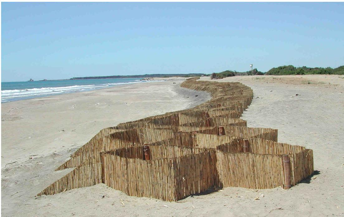
Figure 1 – Exemple de écran brise-vent à échiquier.
