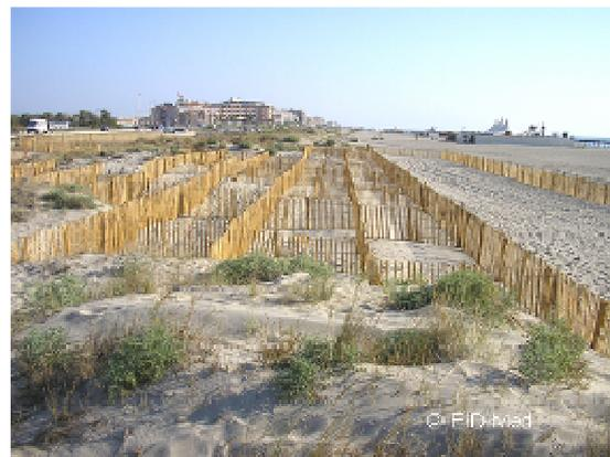
Figure 1 – ouvrages à effet brise-vent: le sable transporté par la mer et le vent sur la plage est capté et stabilisé sur la dune.
