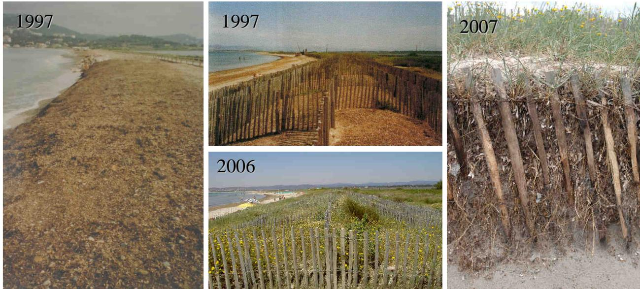
Figure 3 - Exemple de reconstruction d'une dune grâce aux restes de *Posidonia oceanica* et à la plantation d'espèces végétales (Tombolo de Giens, France).
