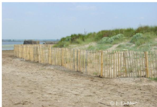
Figure 1 – Exemple de mise en défens d'un cordon dunaire, avec une ligne de ganivelles.
