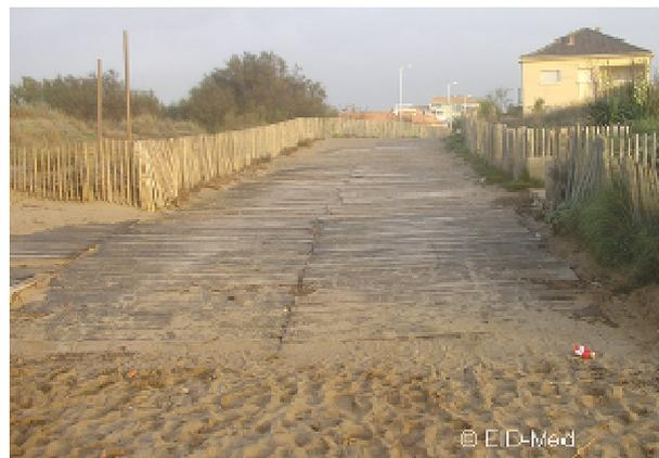
Figure 3 – Exemple de platelage en bois pour le passage des véhicules.
