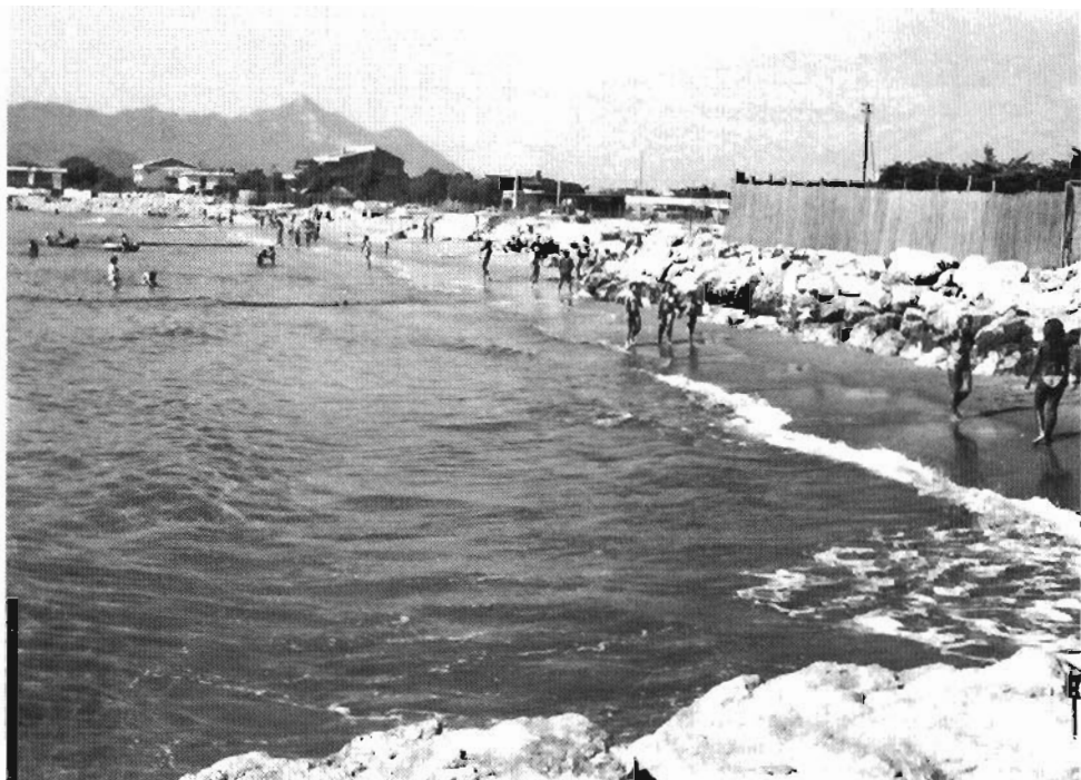
Settembre 1984: Tra Viale delle Ortensie e la foce del Sisto sorgono ormai opere di protezione aderente a difesa di ville e giardini.
