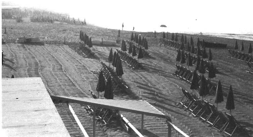
Settembre 1984 dalla copertura dello stabilimento balneare Aurora si nota l'effetto del setto C.
