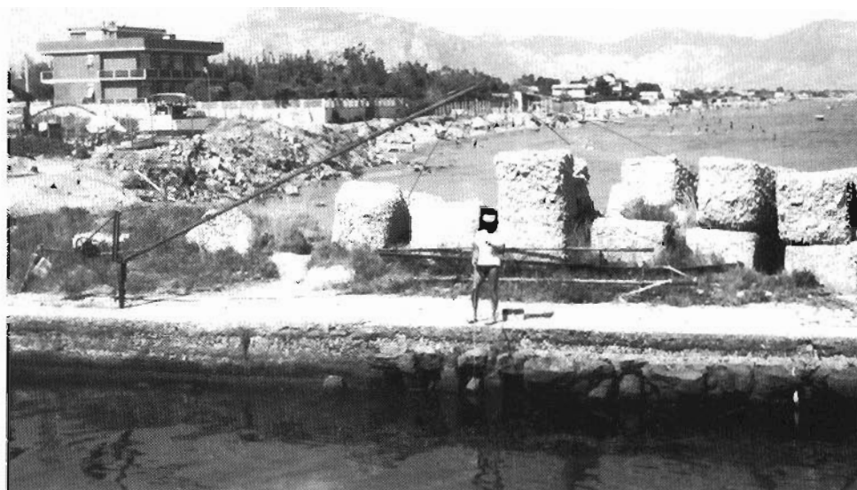
Luglio 1984: dalla stessa posizione della foto precedente, l'arretramento è di circa 30 ml. ed iniziano le opere di difesa aderente.
