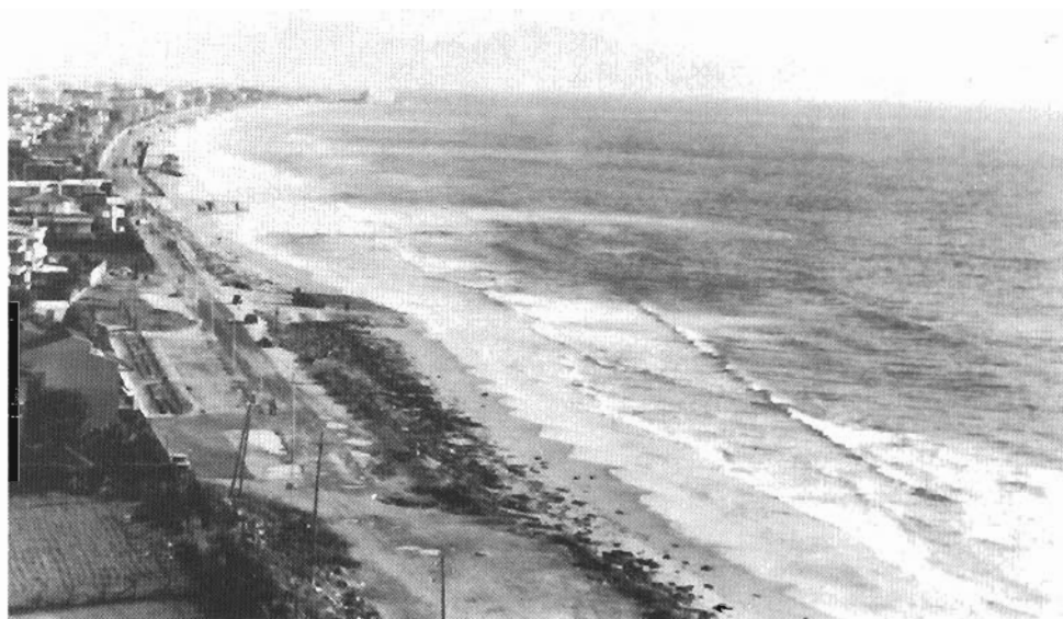
Gennaio 1981: Sono in corso i ripascimenti su tutto l'arco: le strisce di torbidità indicano le posizioni.
