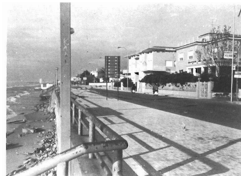
Ottobre 1980: la desolante situazione all'inizio dei lavori.
