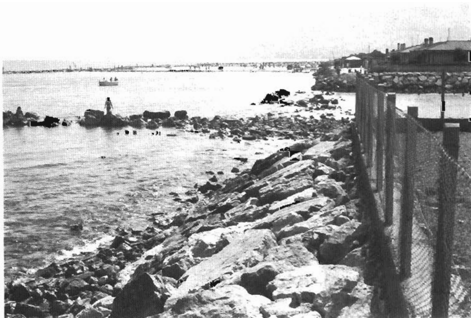
1984; Dalla stessa posizione della foce . precedente si notino i "pennelli" realizzati nel 1982.
