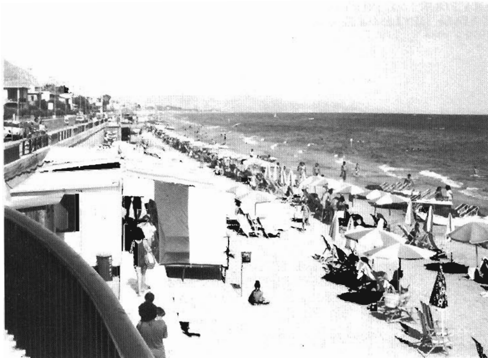
Settembre 1984: In corrispondenza di Via Friuli verso Levante.
