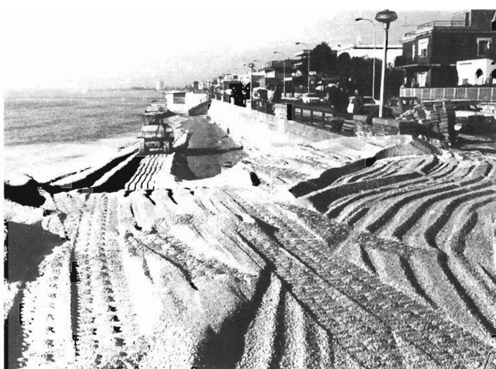
Ottobre 1980: Per evitare il "riflesso" prodotto dal muro il materiale è "disteso" dinanzi.
