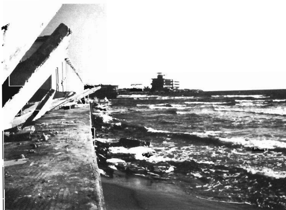
1972: Dopo la costruzione del piazzale a mare per l'Albergo ed in conseguenza della costruzione del Porto di San Felice Circeo, la spiaggia è scomparsa.
