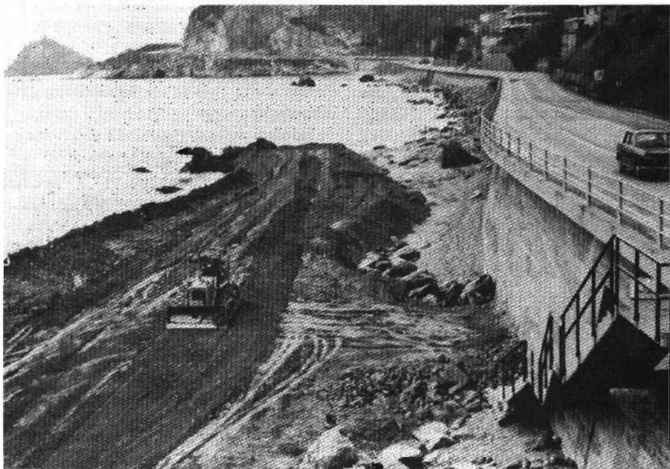
Fig. 118 - Bergeggi: i lavori per la realizzazione della nuova spiaggia vengono iniziati con un versamento aderente.
