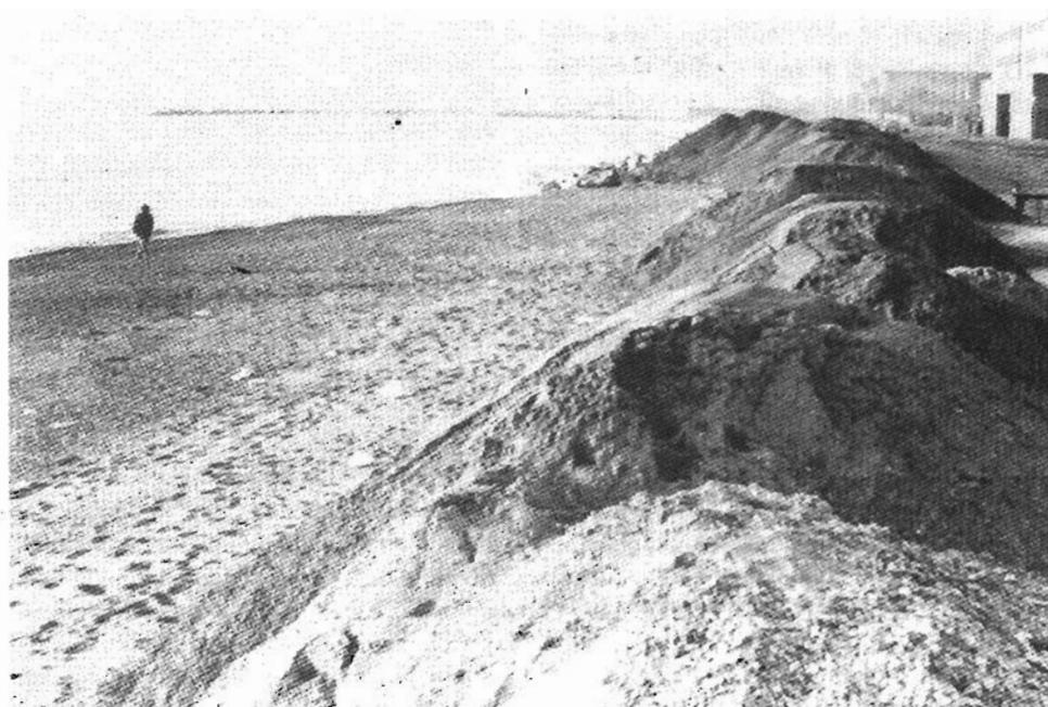
Fig. 115 - Marina di Massa: il materiale di ripascimento è versato in aderenza alla strada a mare; in occasione delle mareggiate compenserà l'erosione (Foto Egori).
